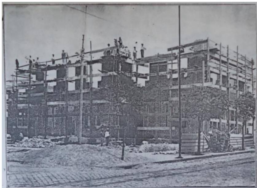
Figura 14: Construção do edifício, 1927 Fonte: SEEC-PR - CPC
