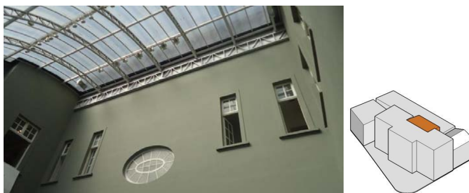
Figura 23: Sala Theodoro de Bona, vista para a parte posterior do edifício 1 Fonte: Ary Ney Chaicoski Junior, 2017
